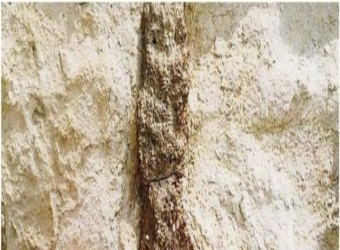
Рисунок 1.3– Использование гипсового раствора для скрепления блоков
